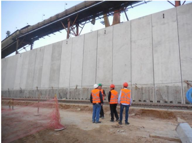
Parede do novo armazém 39 em concreto pré-fabricado.
