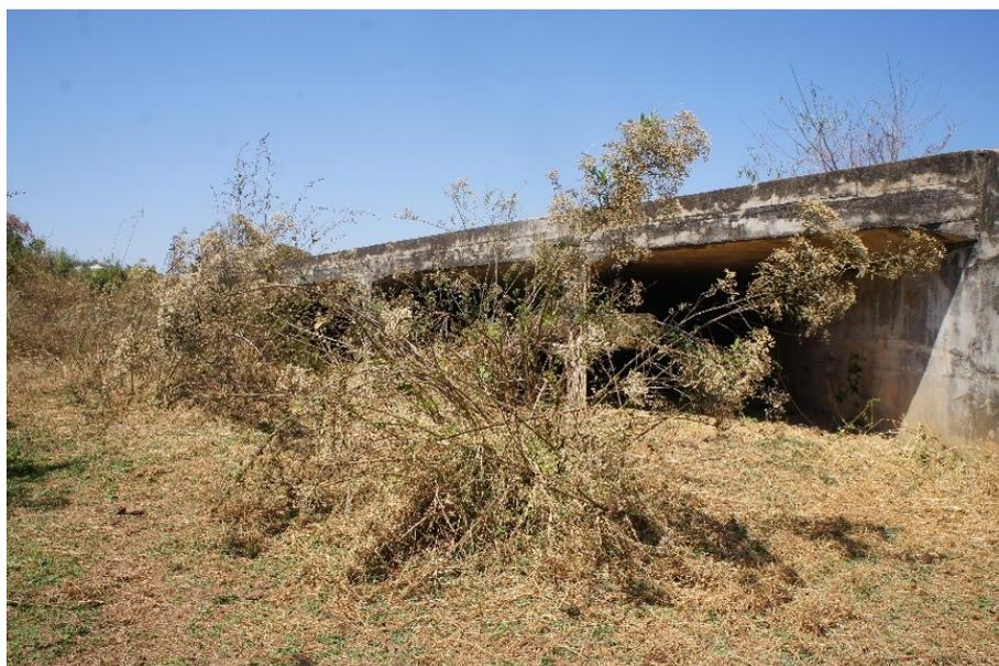
Foto 17 – Bueiro Triplo Celular de Concreto - BTCC
