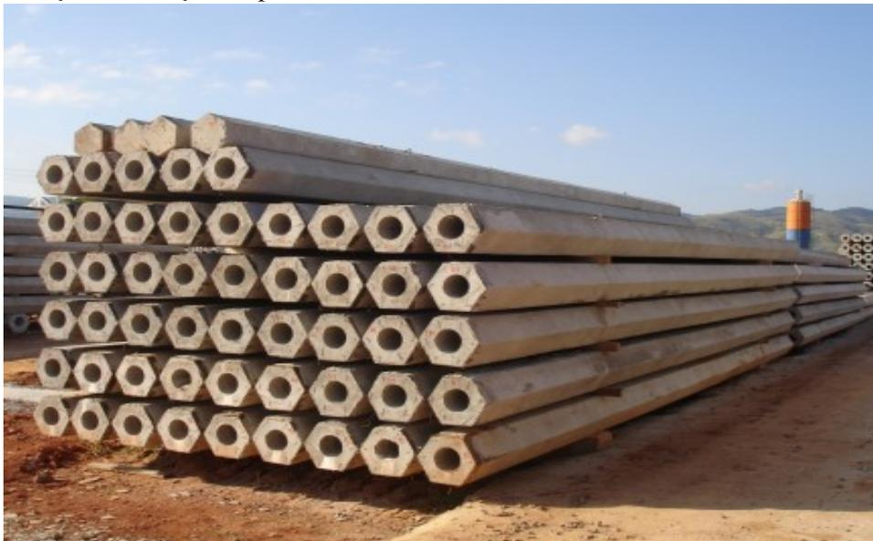
Foto 5 – Estacas de concreto pré-moldado.
