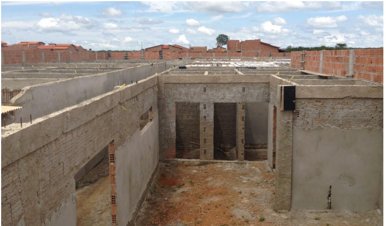
Foto interna, tirada do alto da obra do hospital: quase totalmente concluídos alvenaria e reboco; iniciada parte da cobertura;
