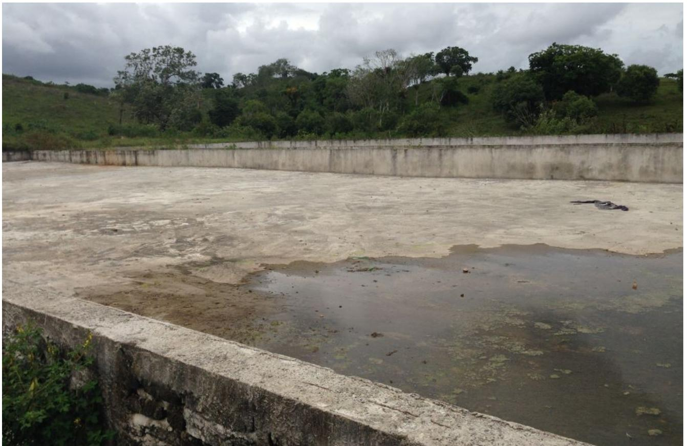
Leitos de secagem da ETE do SES de Itabuna. Não foram iniciados a tubulação do leito de secagem, os Digestores Anaeróbios de Fluxo Ascendentes (DAFAS) e as valas de filtração (WET LANDS).
