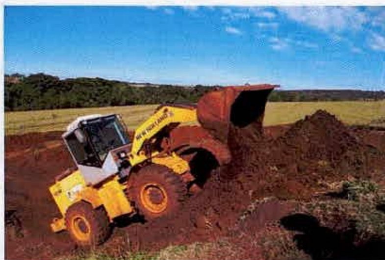
Execução de caixas de captação para combate a erosão nas áreas destinadas a reserva
