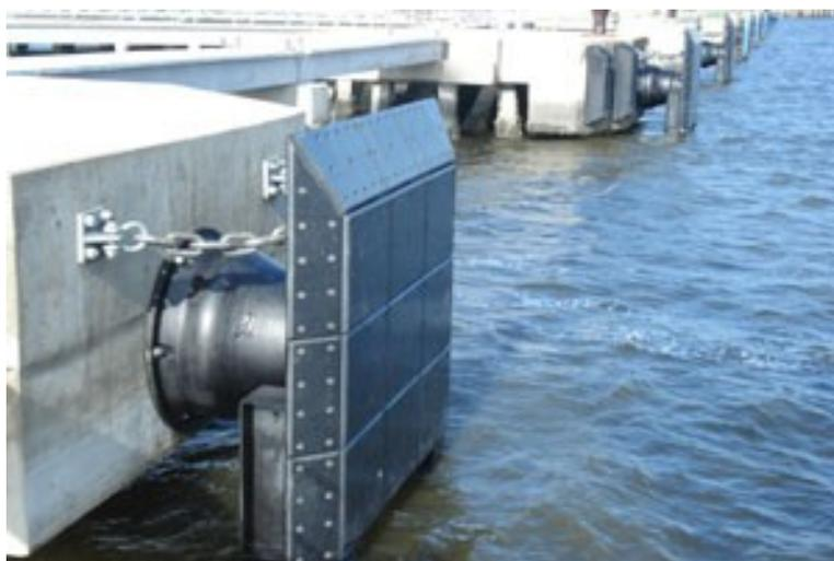
**Fig. 2 – Conjuntos de defesa formados por um elemento de borracha tipo cônico.**
