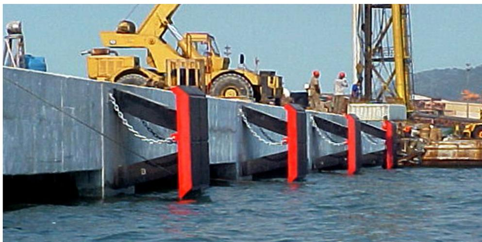
**Fig. 4 – Conjuntos de defesa formados por dois elementos de borracha tipo  $\pi$  ( $\pi$ ) ou modular.**
