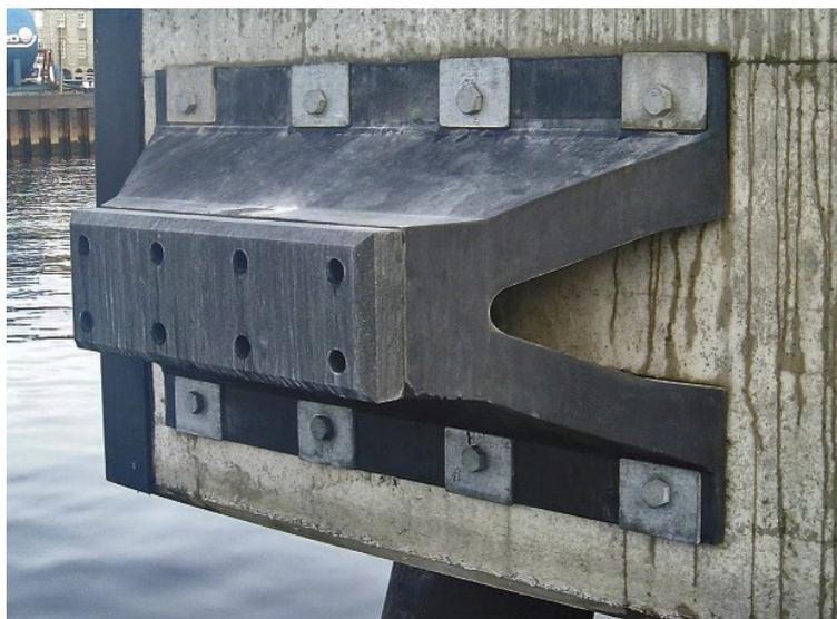
**Fig. 3 – Conjunto de defesa formado por um elemento de borracha tipo ‘V’ ou arco.**
