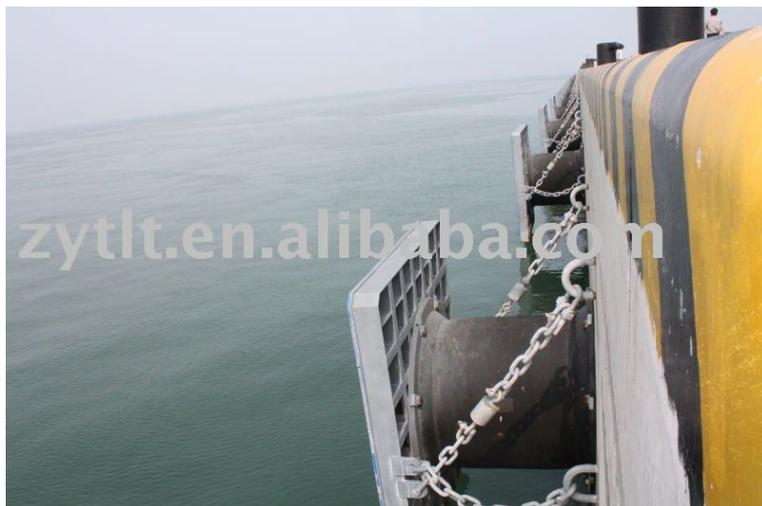
**Fig. 1 – Conjuntos de defesa formados por um elemento de borracha tipo cilíndrico axial.**
