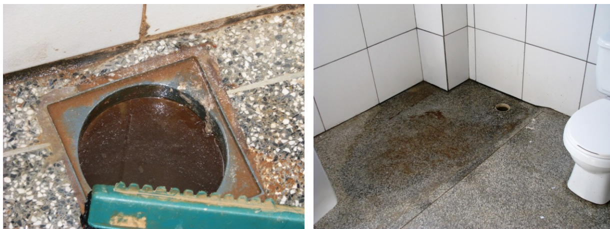
Figura 7 – Exemplos de ralos entupidos nas UPA 24h em Rondônia.
