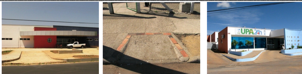
Figura 13 – Acima, exemplo de rebaixamento de calçada, segundo item 6.10.11.13 da NBR 9050. Abaixo, calçadas de Oeiras/PI, Porto Alegre/RS e Formosa/GO.
