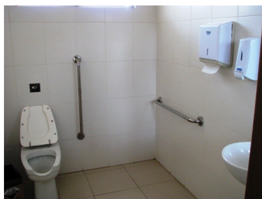
Figura 10 – O posicionamento das barras de apoio, segundo a NBR 9050, e imagem das barras mal posicionadas na UPA 24h em Novo Hamburgo/RS
