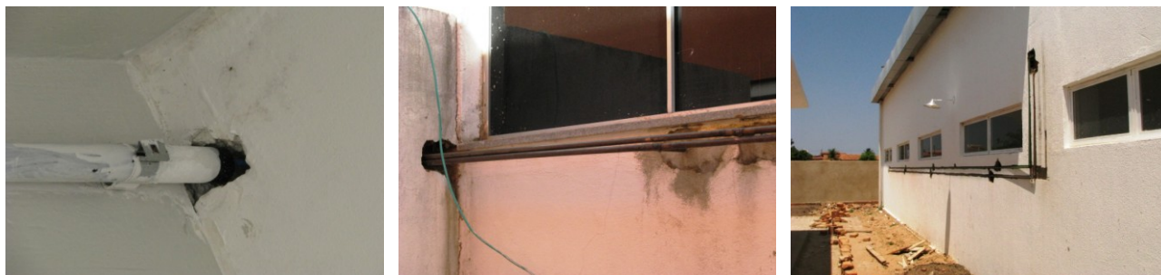
Figura 8 – Tubulações executadas depois das obras prontas em Formosa/GO (esquerda e centro) e Oeiras/PI.
