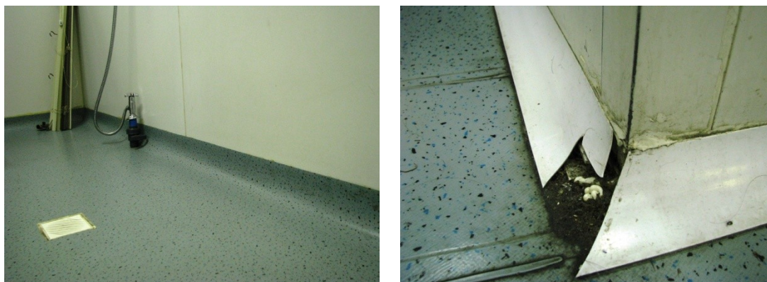
Figura 1 – À esquerda, rodapé e piso formam um conjunto monolítico de manta vinílica. Contudo, o modelo mais encontrado de rodapé foi o da imagem à direita.
